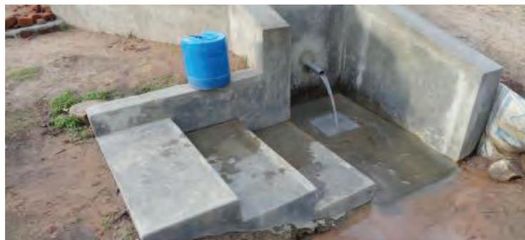
Après: source d'eau de Kakemer protégée; structure en béton qui protège l'eau de la contamination extérieure. Accès sécurisé.
