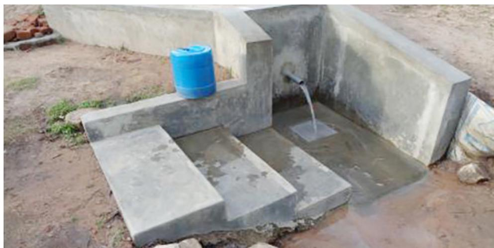
Après: source d'eau de Kakemer protégée; structure en béton qui protège l'eau de la contamination extérieure. Accès sécurisé
