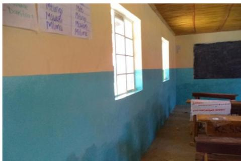
Après: sol en ciment, fenêtre vitrée et plafond isolant
