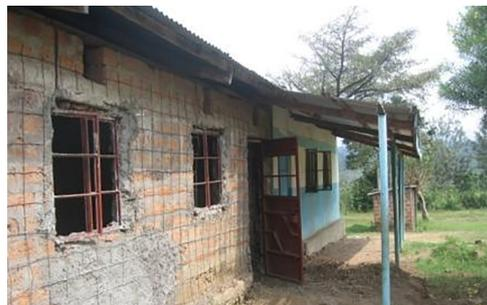
Avant travaux: mur de façade détérioré et renforcé
