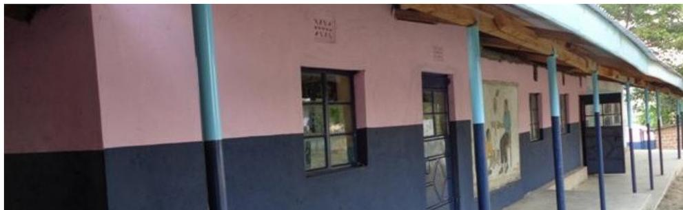
Après travaux: mur renové, fenêtres et portes vitrées, toit réparé, auvent contre la pluie
